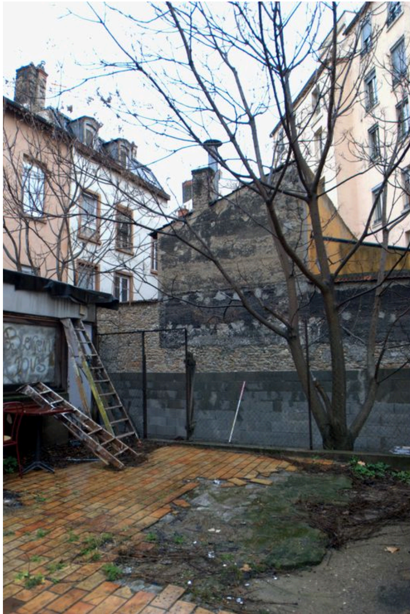
Elévation postérieure depuis le sud-ouest et du mur mitoyen construit en galets
