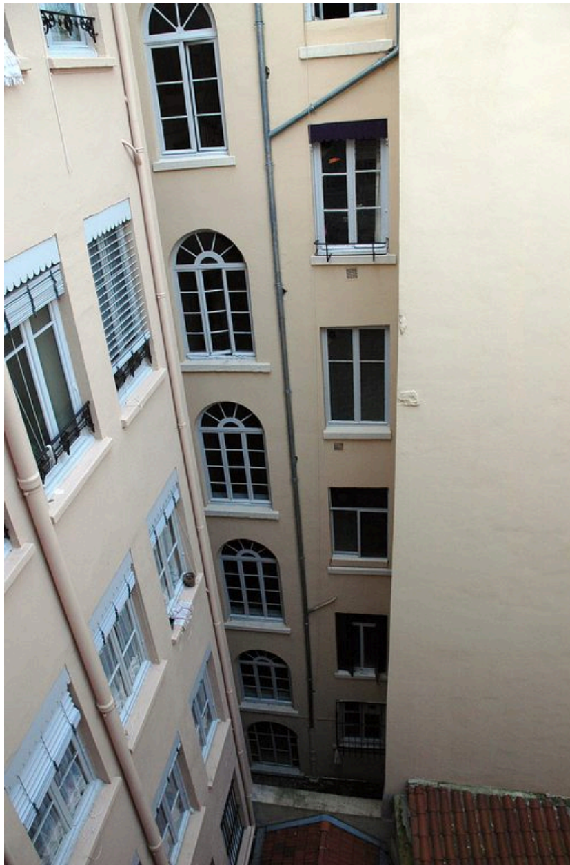
Elévation sur cour depuis la cage d'escalier de l'immeuble sis 70 rue du Président-Edouard-Herriot
