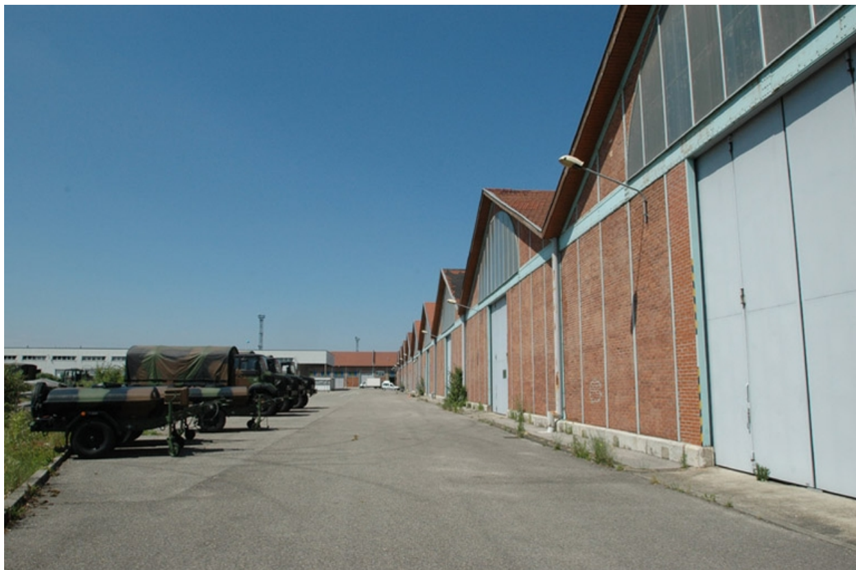
Vue sud des entrepôts n° 15
