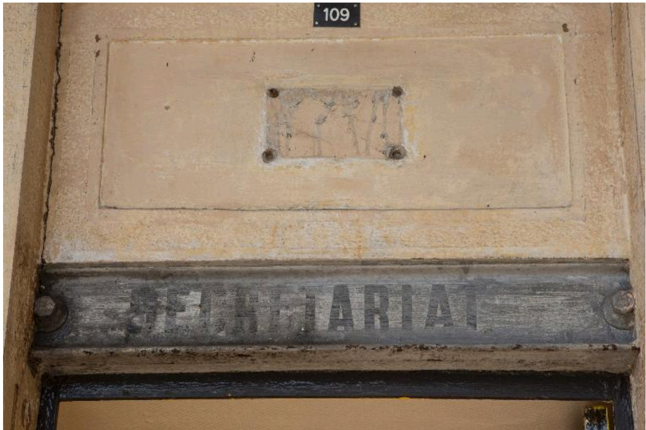
Bâtiment A. Imposte des salles : secrétariat
