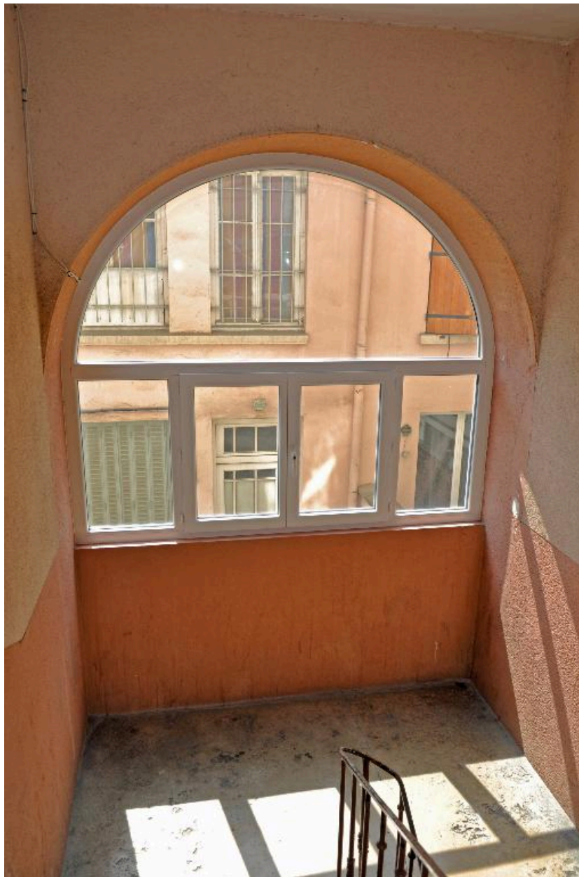
Vue intérieure d'une des baies éclairant les paliers de l'escalier
