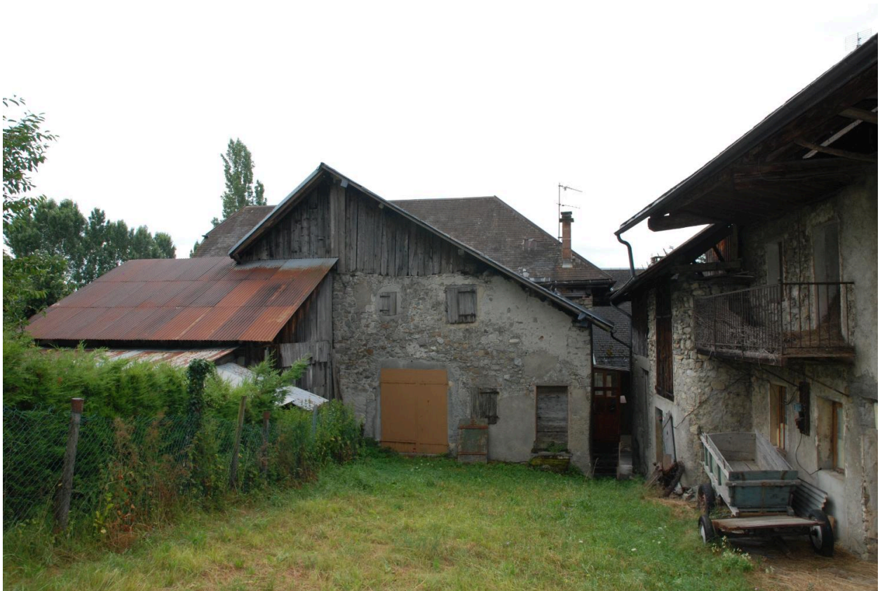
Maison, ferme (2018 E3 992, 990, 989, 988). Vue du nord-est.
