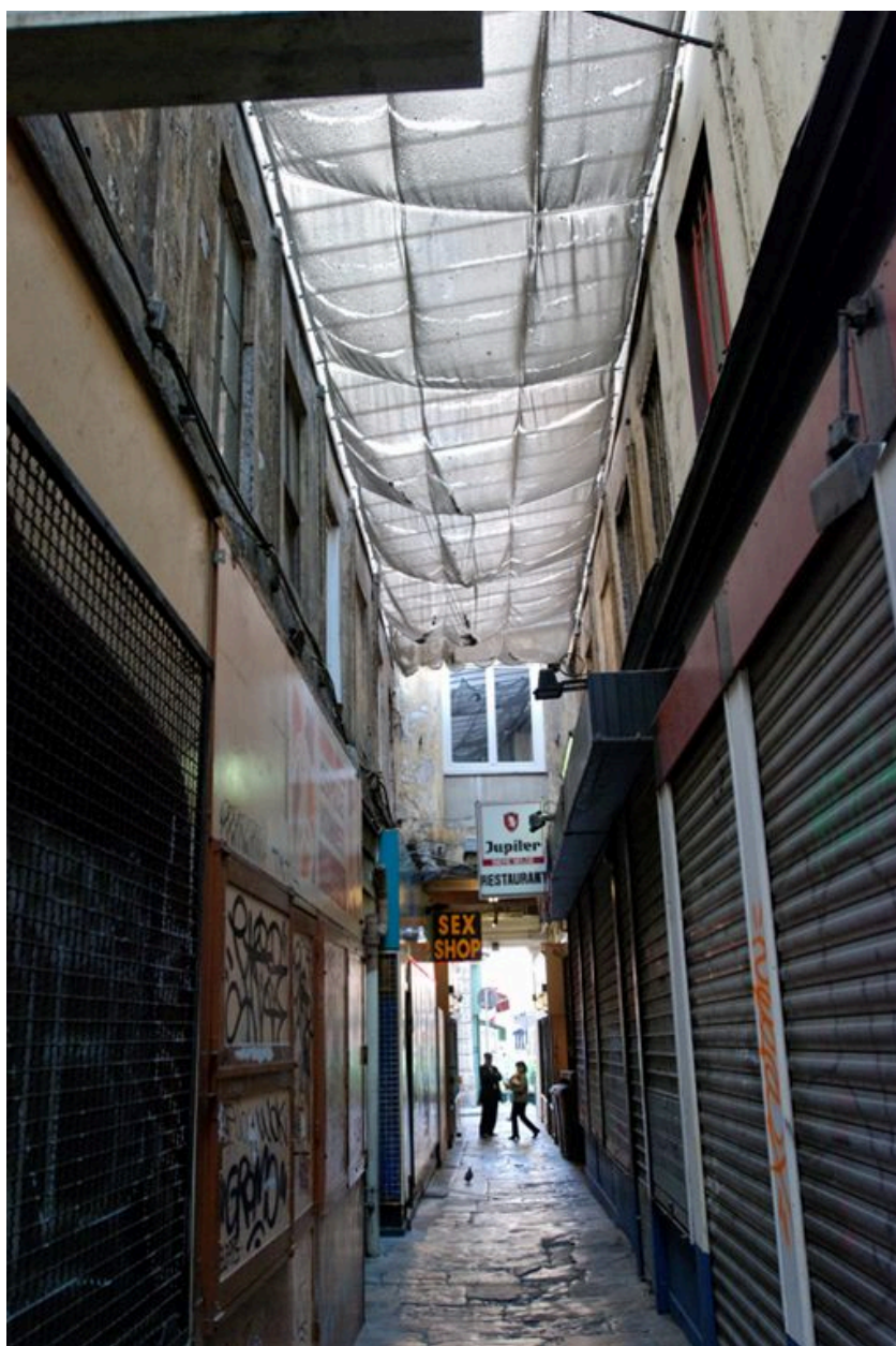
Vue partielle, partie nord, depuis le sud
