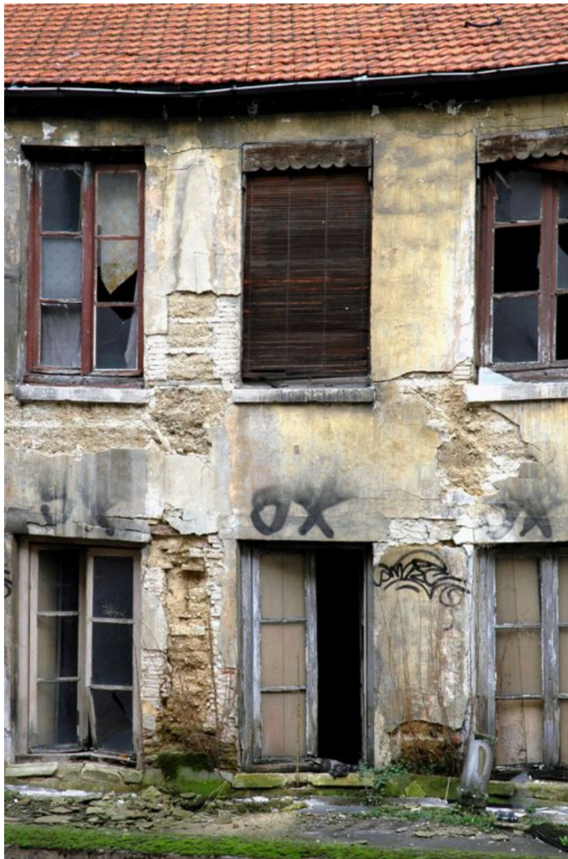
Détail de l'élévation antérieure
