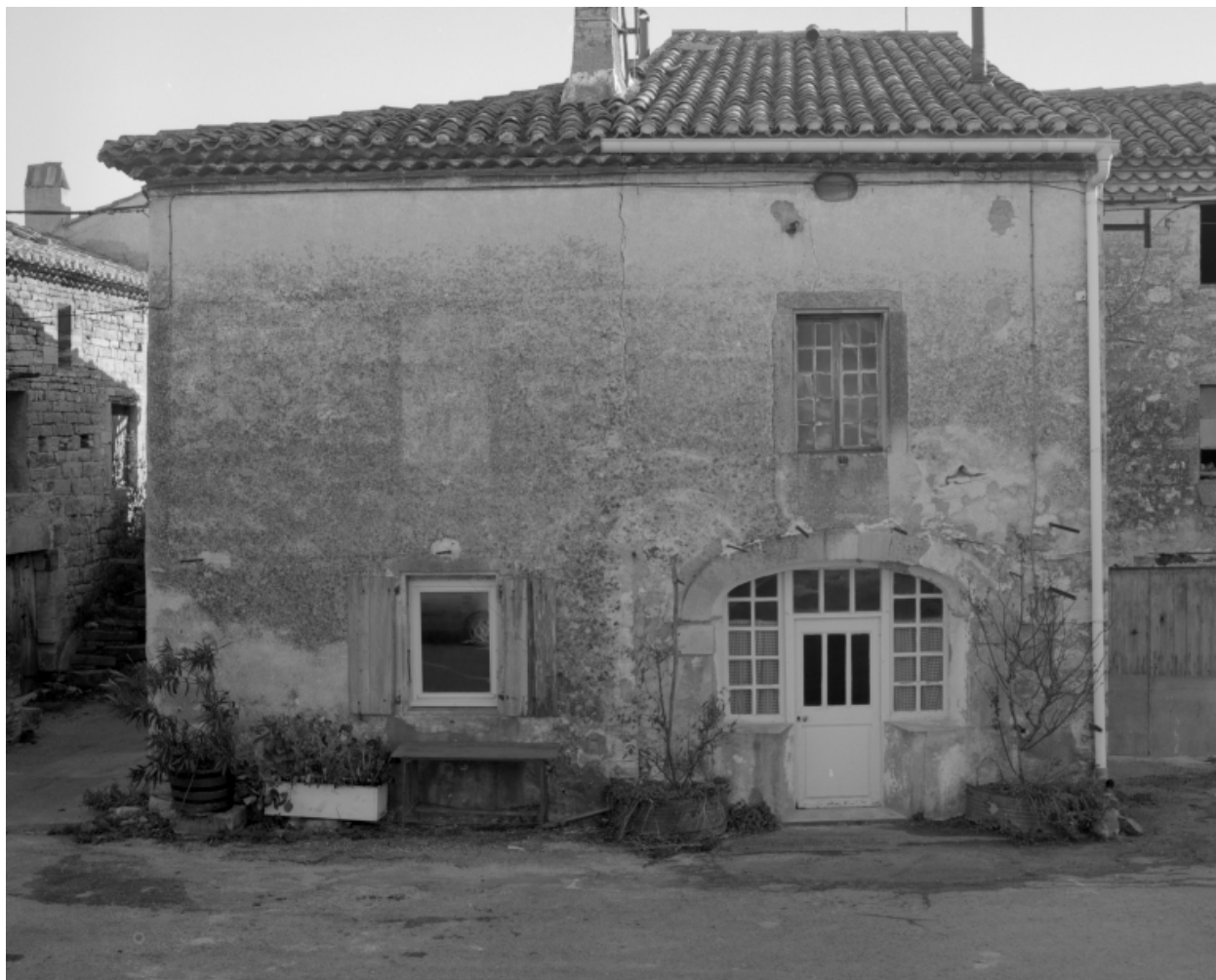
Le village. Façade sud de la maison (A1 159), sur la place.
