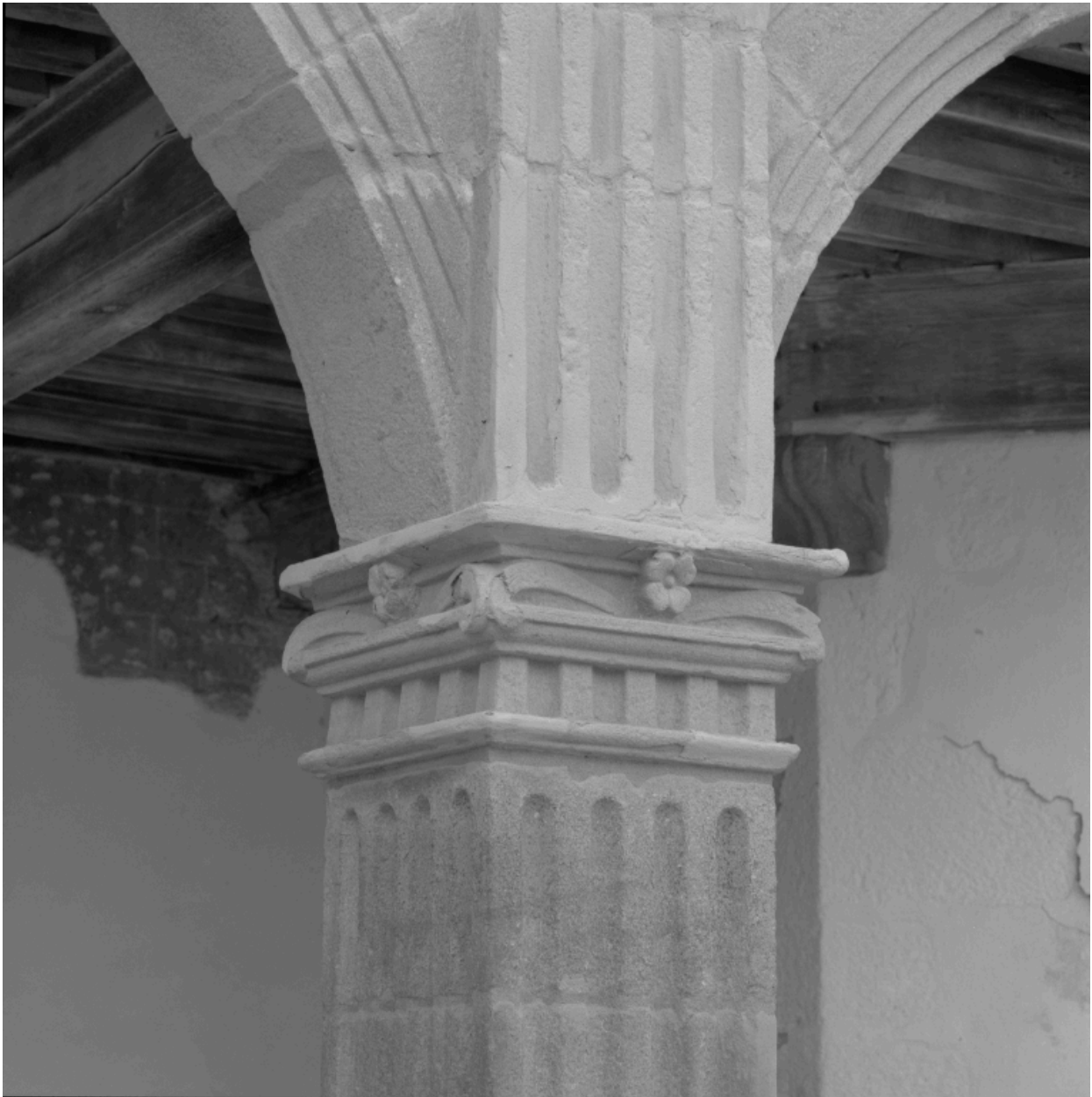
Corps de galerie : de droite à gauche, détail du 3e chapiteau bas du portique.
