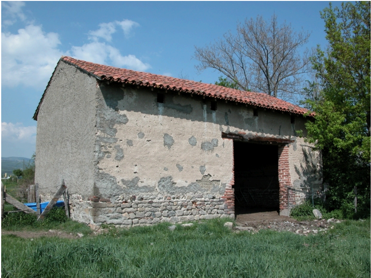
Grange-étable isolée à Bicêtre (1997 AC 2).
