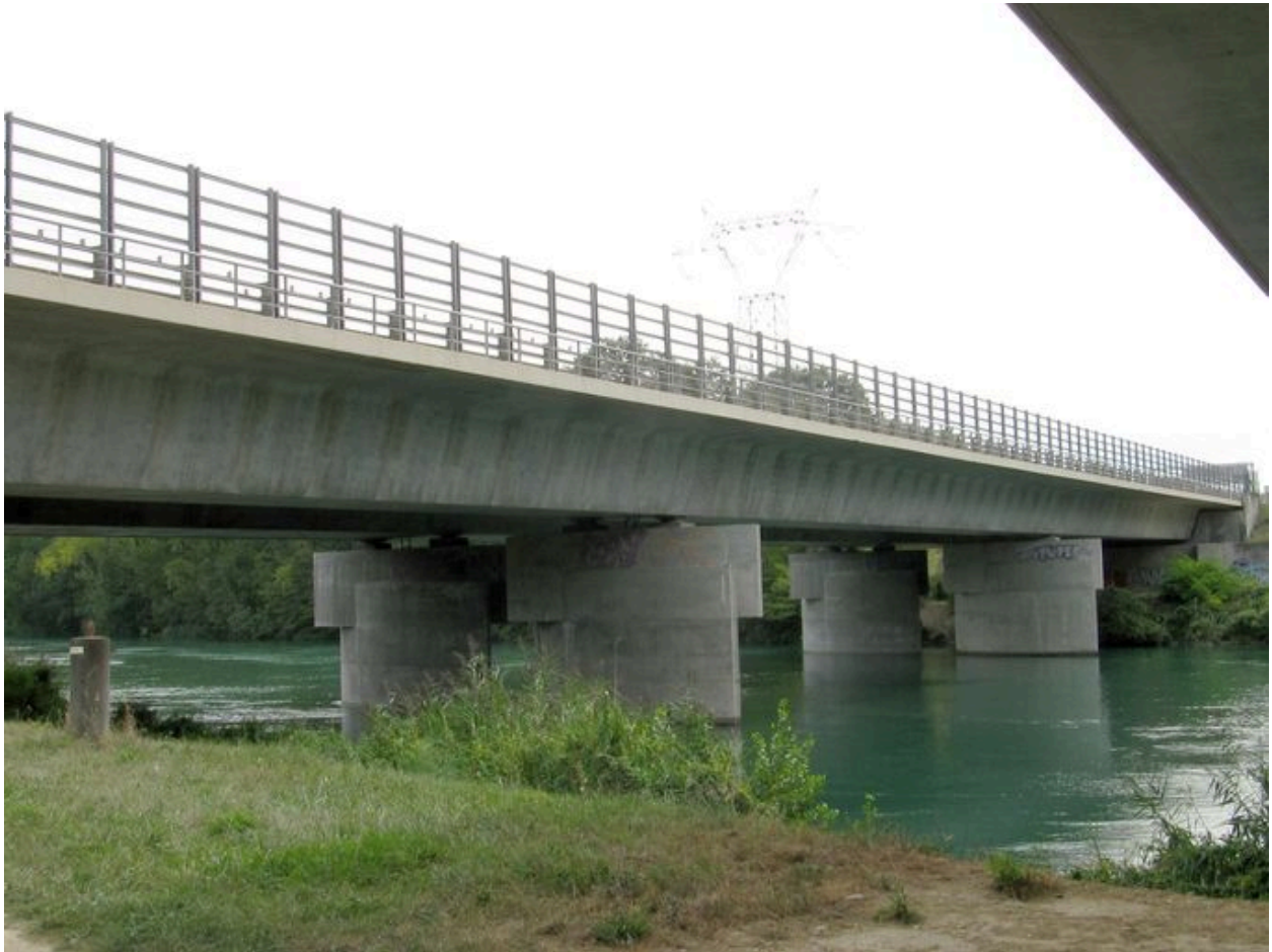
Vue générale de la partie du pont sur le canal de Jonage, face aval (depuis la rive droite)
