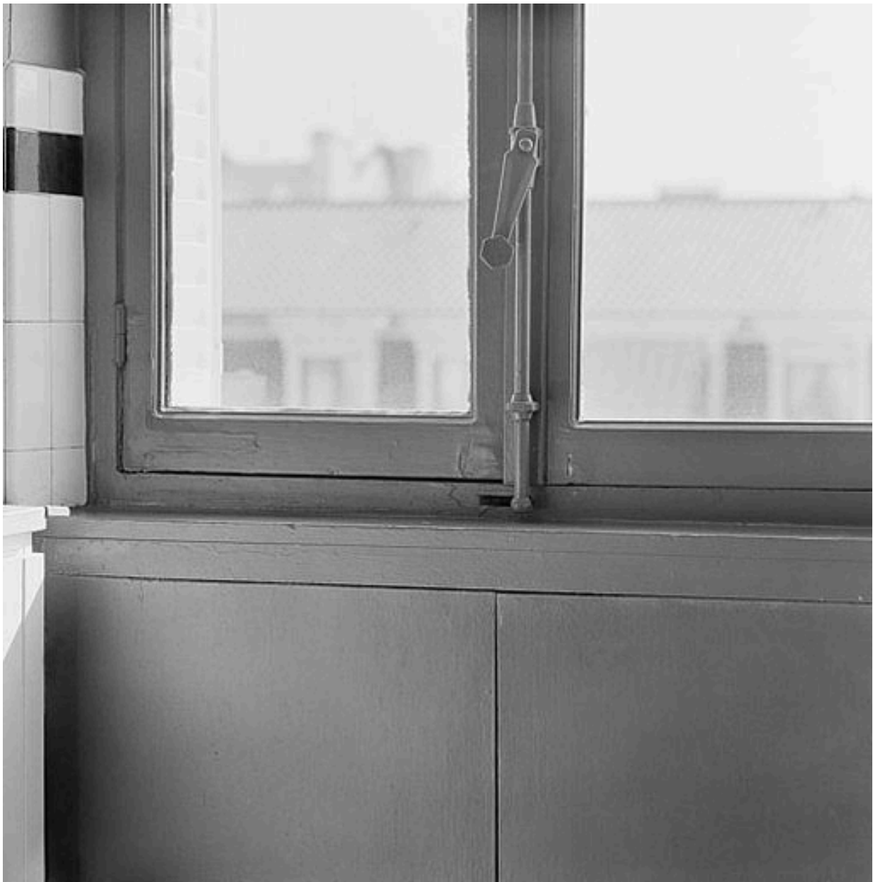
Espagnolette, fenêtre de la cuisine d'un appartement
