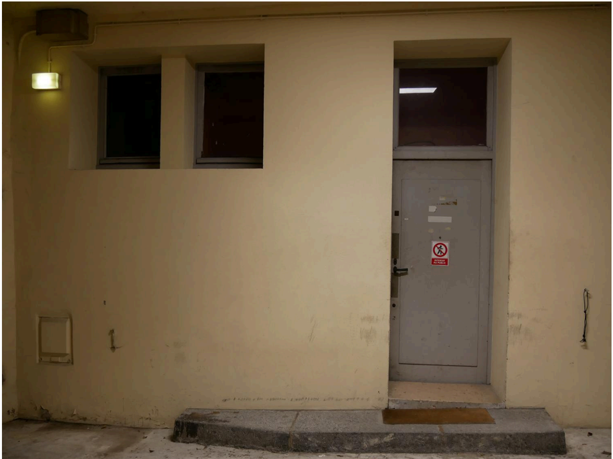
Entrée sur cour : Bains-douches Bourgogne-Vaise
