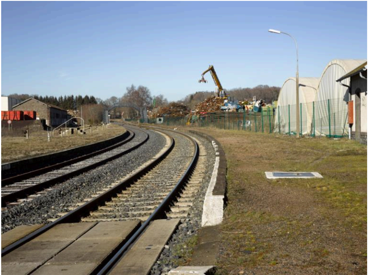
Ferrailleuse en bordure de voie ferrée, entre Saint-Ours et Beauloup.
