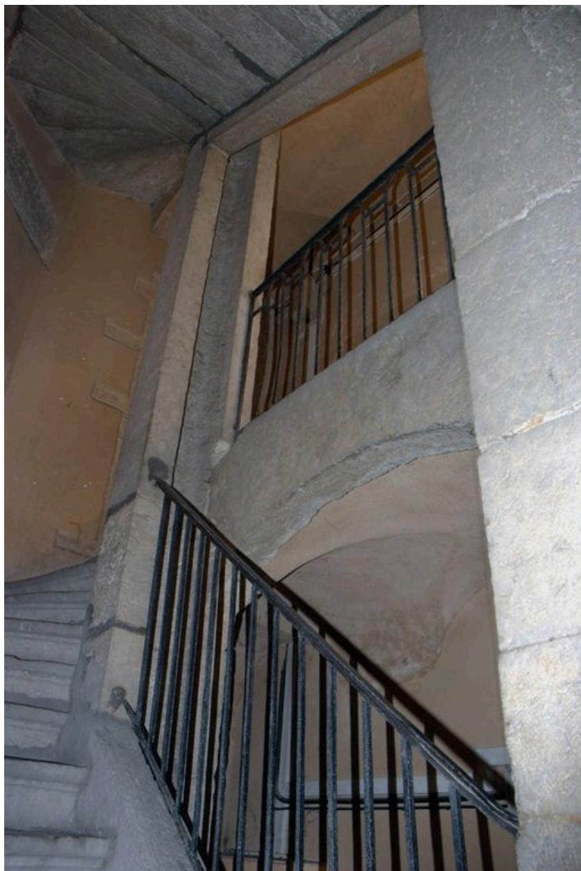
Escalier, vue de la première volée
