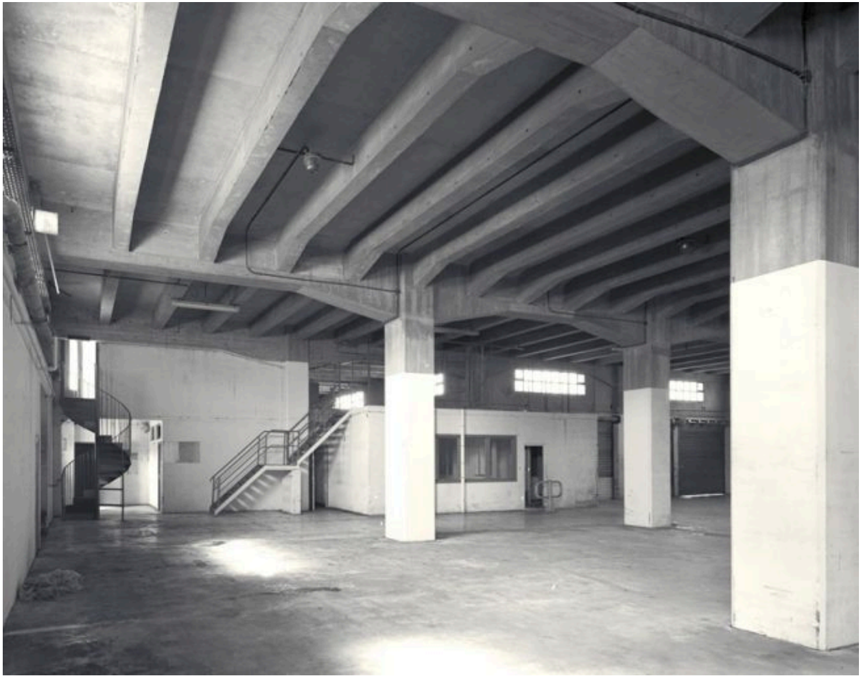
Intérieur du bâtiment de 1960 (bâtiment nord) : vers les bureaux et vestiaires
