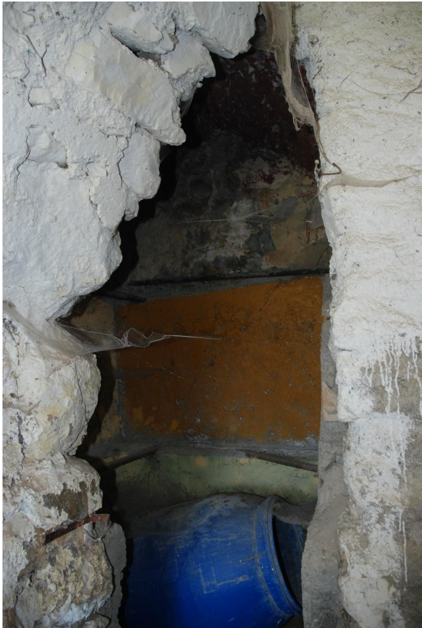
Bâtiment de dépendances, étage de soubassement, vue intérieure : dernière cave à l'ouest, puisard (?) dans l'angle nord-ouest.
