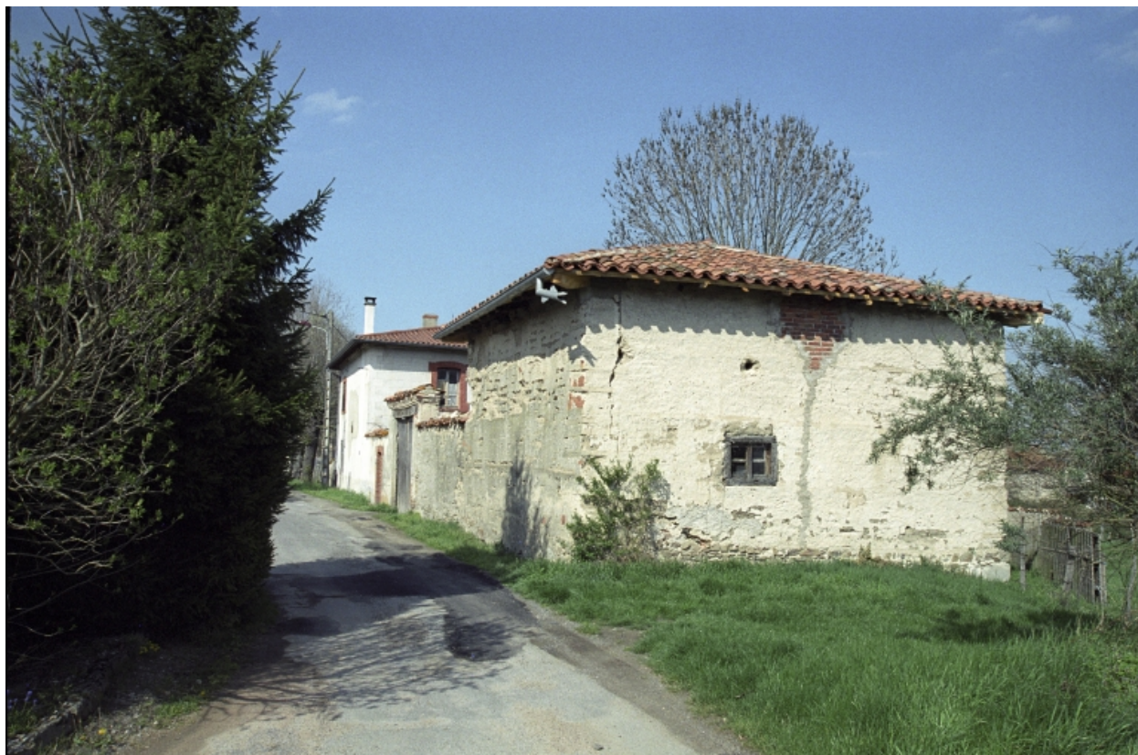
Vue générale depuis le chemin, en direction du nord.
