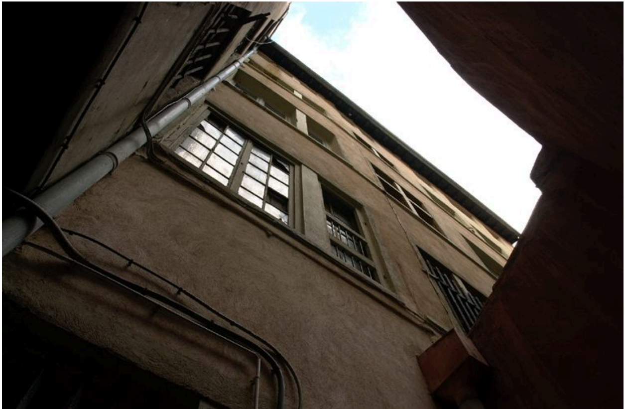
Vue générale depuis la cour
