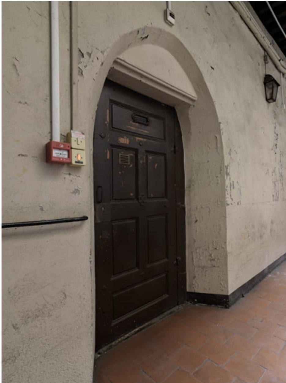
Bâtiment R. 1ère porte de la galerie du 1er étage
