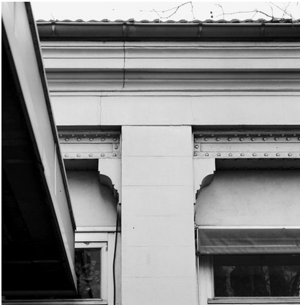
Pavillon des Bains (13), aile basse, détail des baies ouvrant sur la terrasse du bâtiment 12
