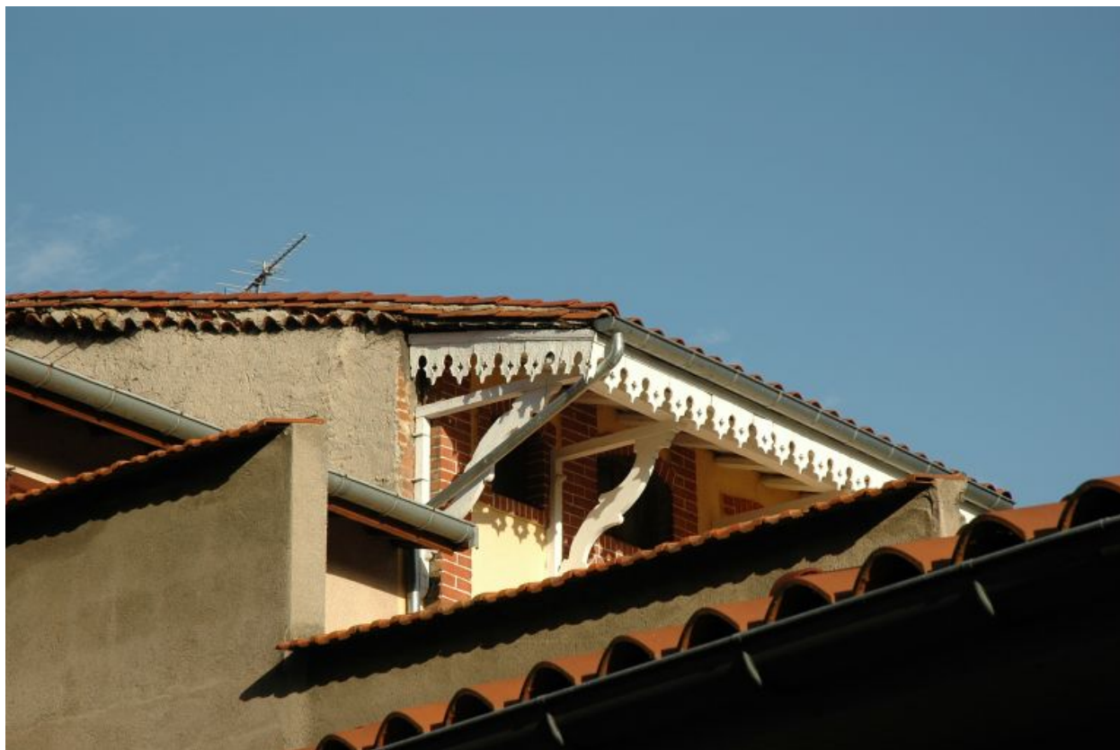
Vue partielle de l'élévation postérieure.
