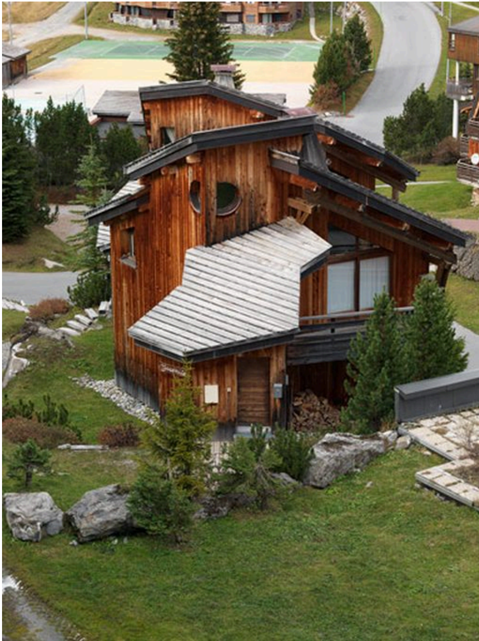
Vue d'ensemble depuis l'ouest
