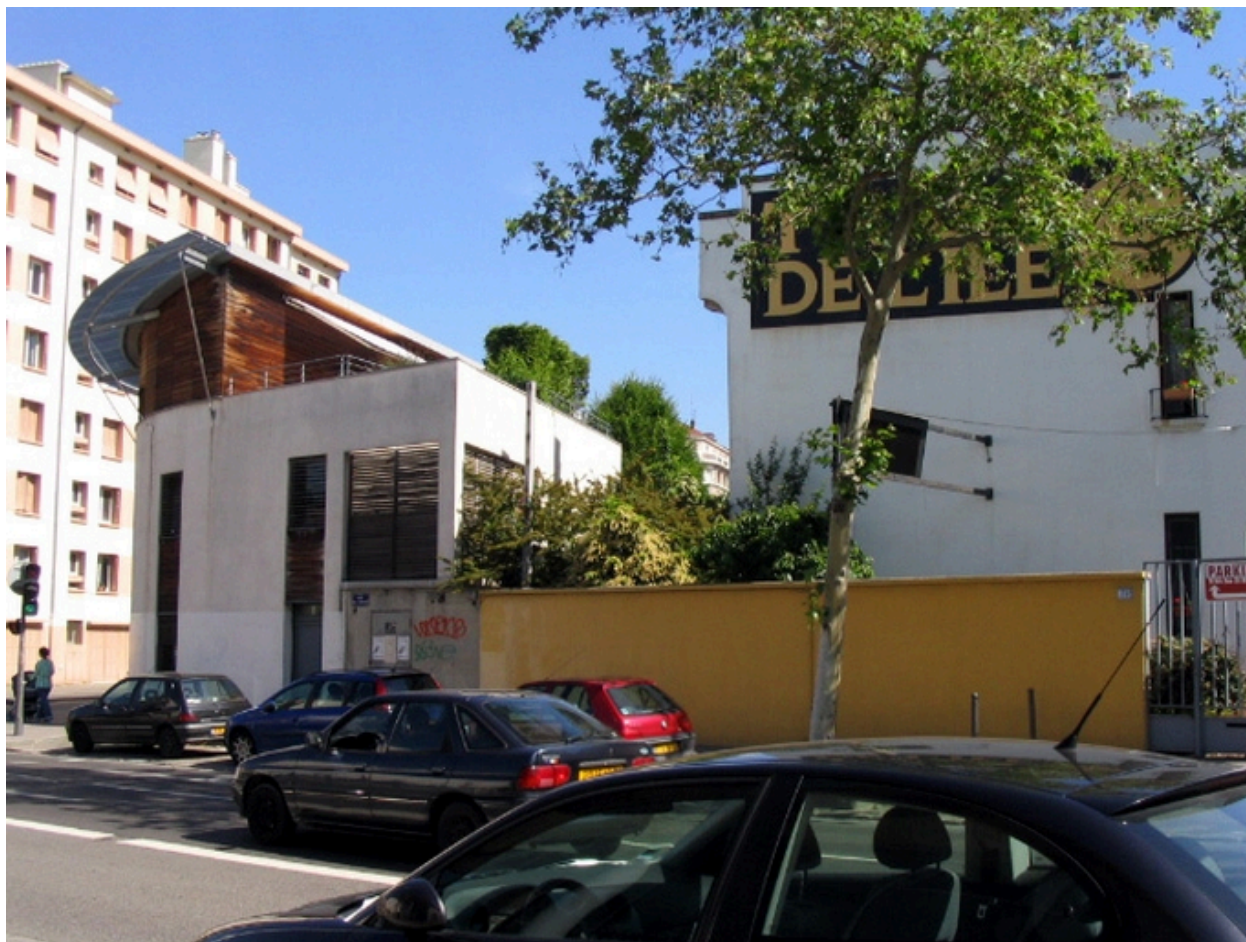
Extension et dépôt vente (façade rue Marius Berliet)
