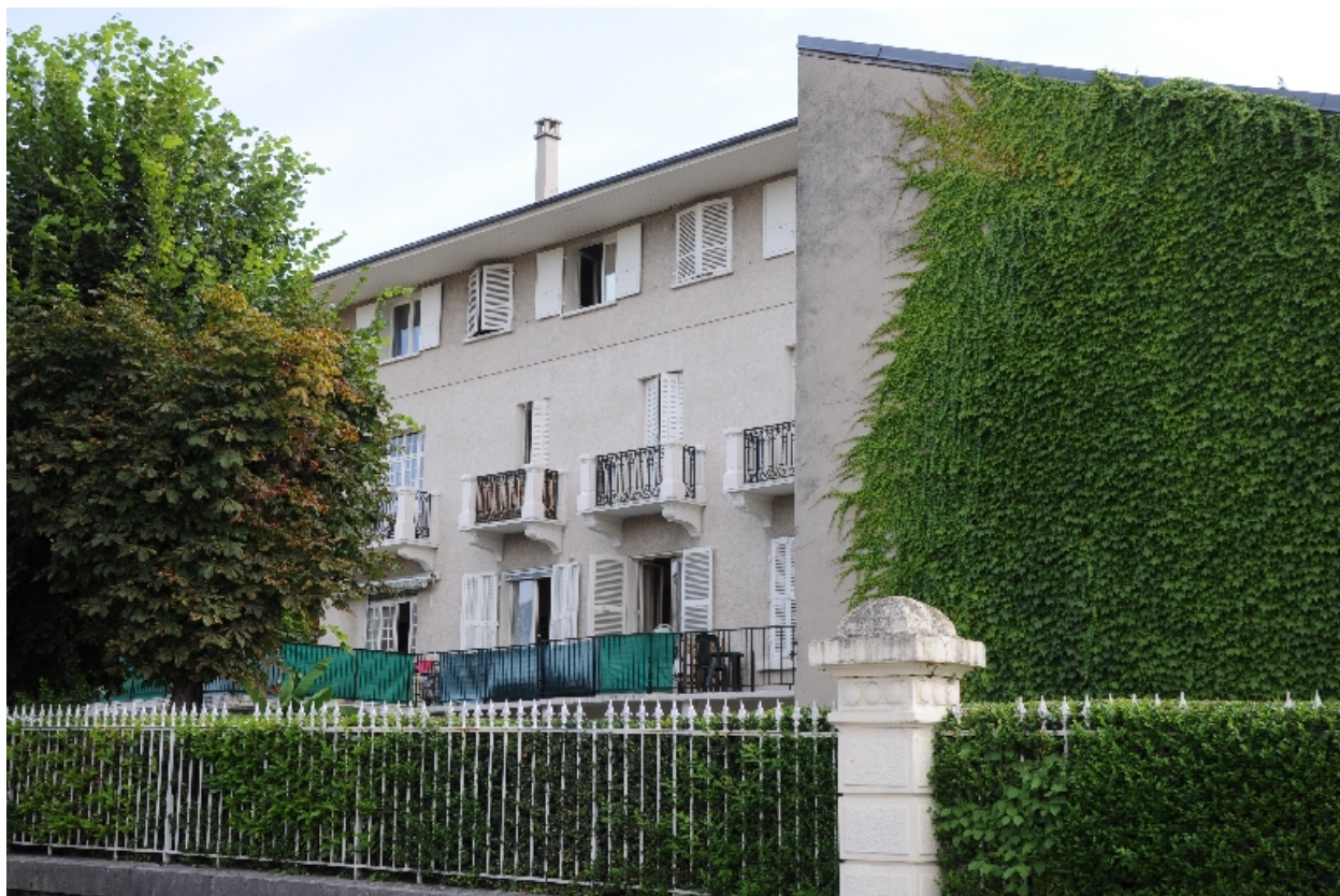
Façade principale, sur rue
