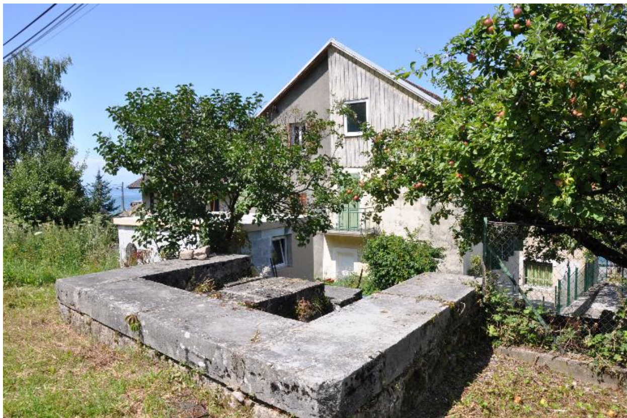
Vestiges des salles d'eau aménagées en amont des moulins
