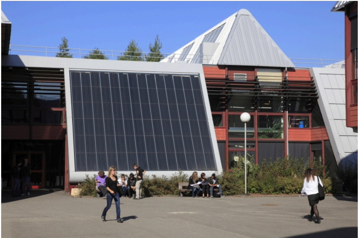
Cour intérieure, façade nord du bâtiment A. A droite, le bâtiment E.
