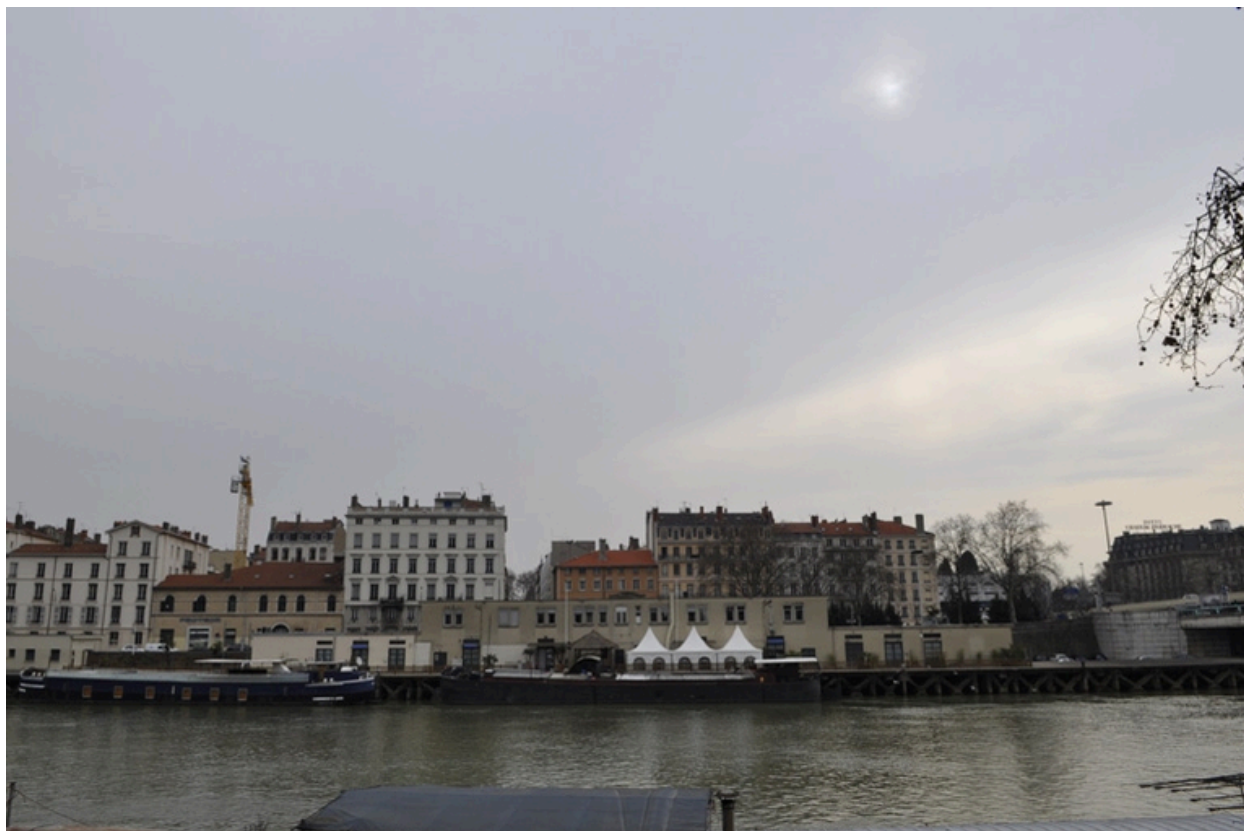
Vue d'ensemble ouest
