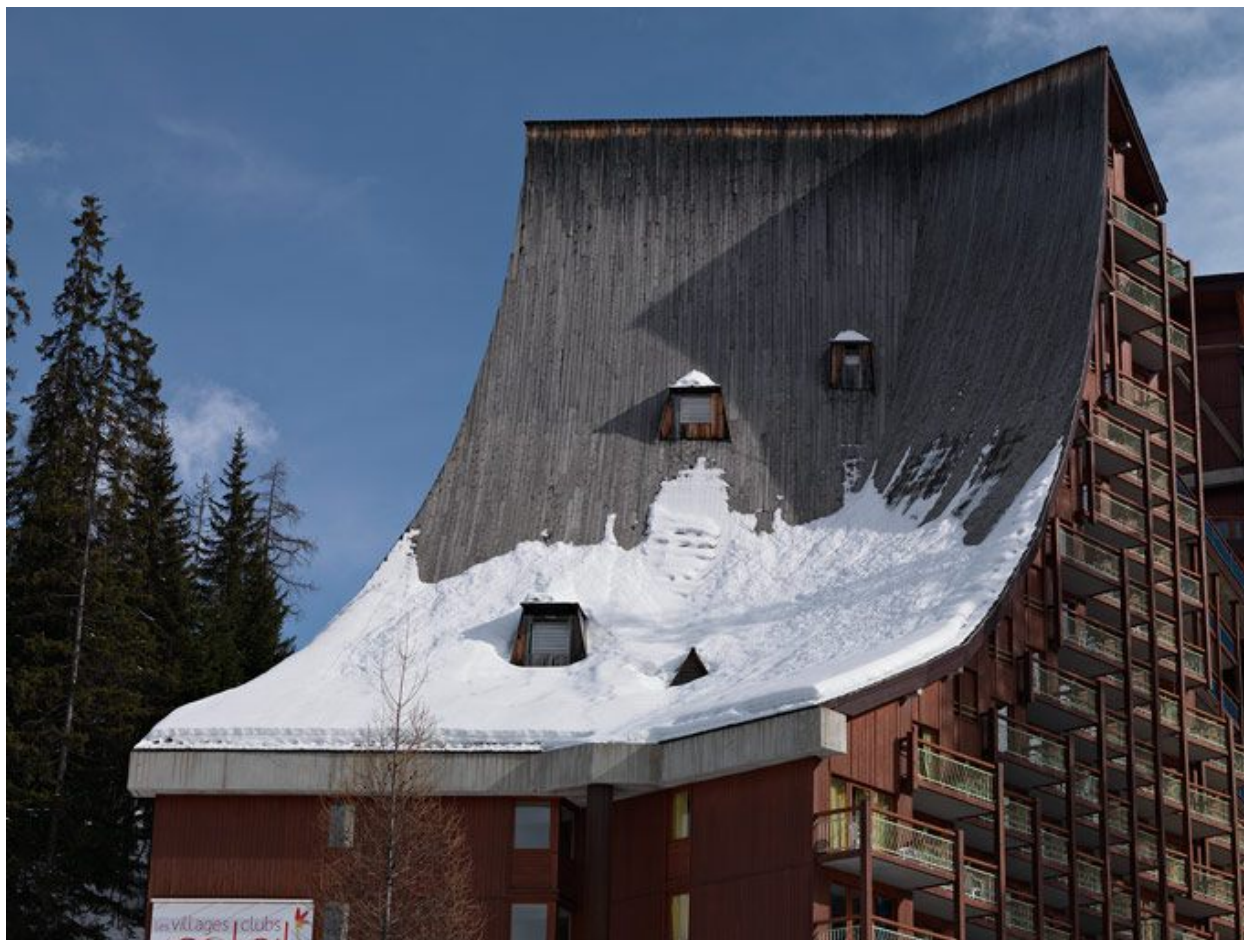
Toiture du corps de bâtiment ouest
