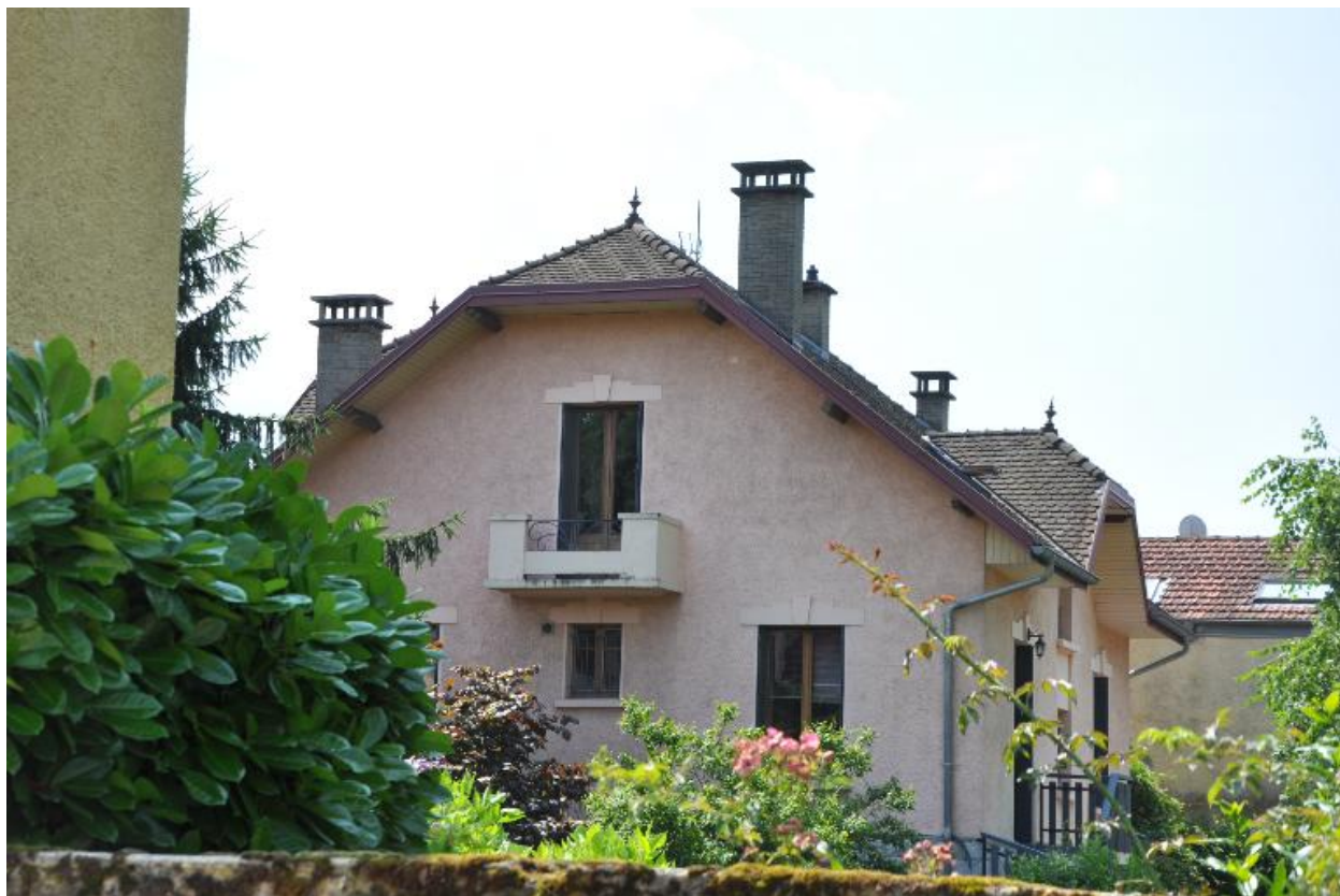
Façade latérale nord
