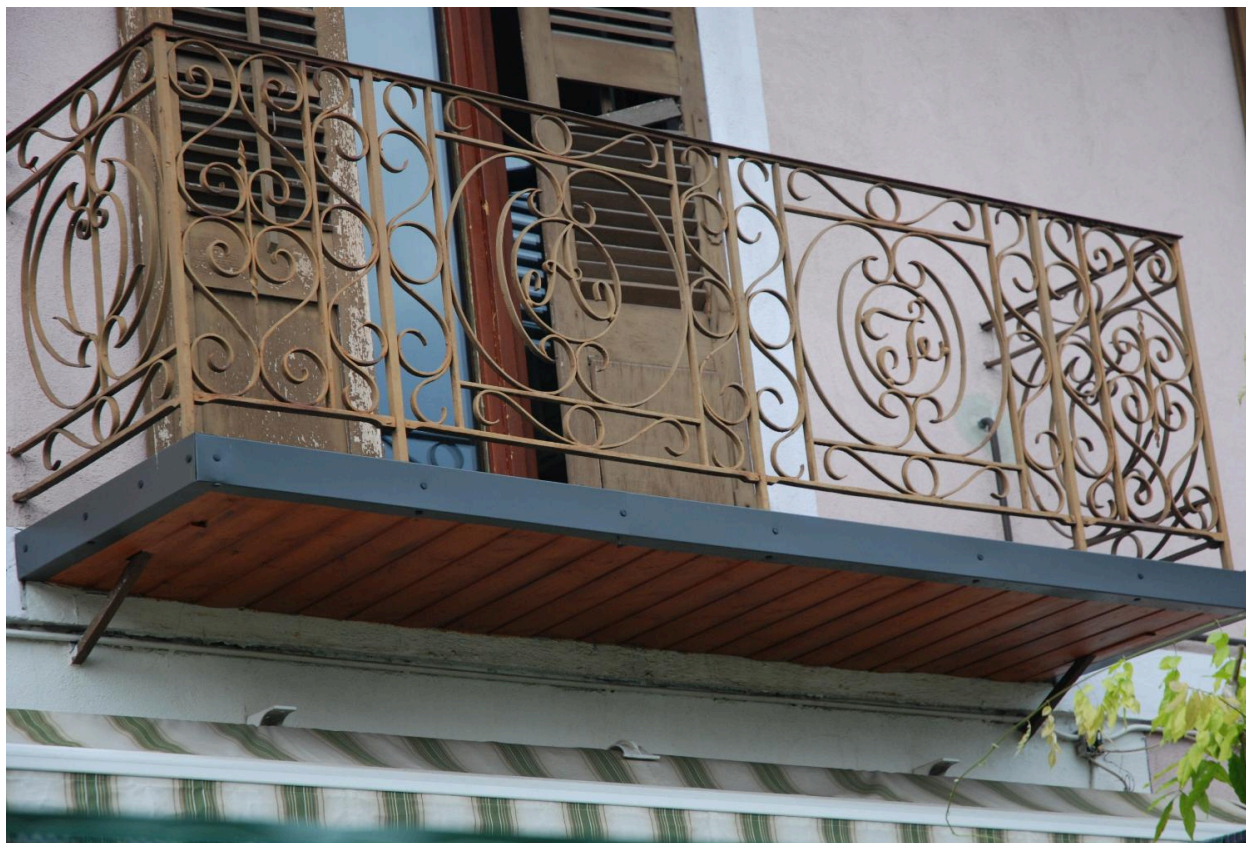
L'hôtel de la Gare (2018 D2 1977) : détail du balcon du 1er étage (initiales A F).
