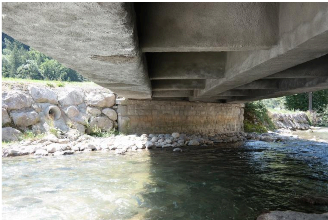
Pont d'Abondance, vue de dessous
