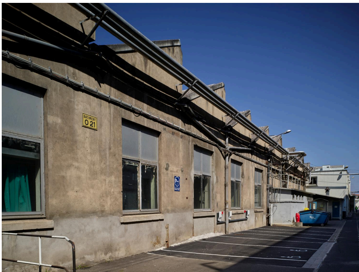
Élévation partielle sud du bâtiment O21.
