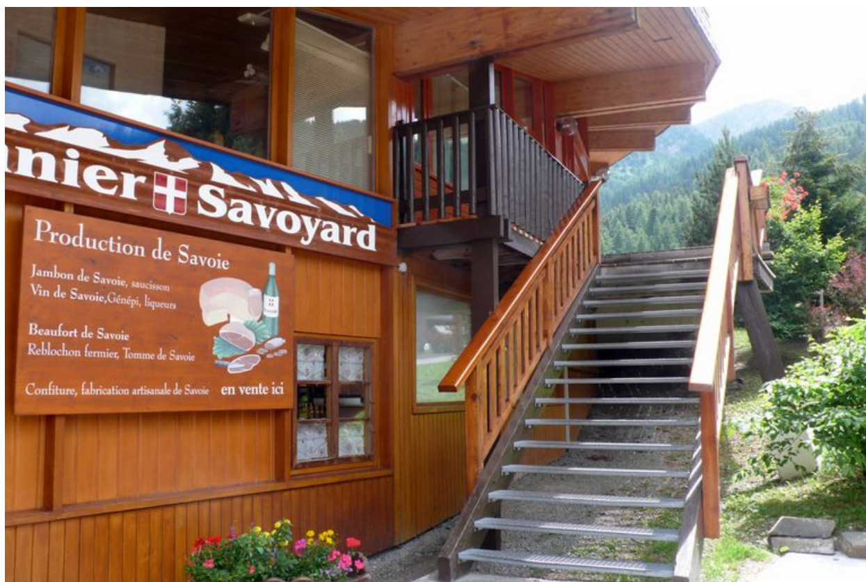
Un escalier extérieur
