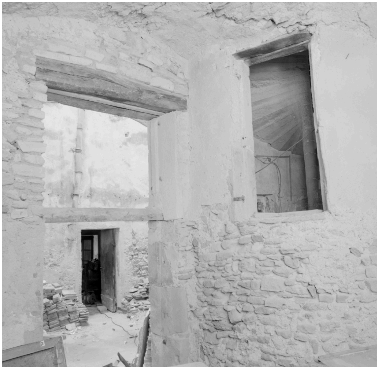
Corps sud donnant sur la cour intérieure et cage d'escalier en vis.
