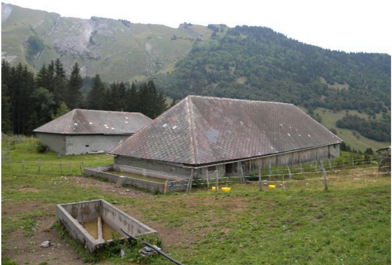
Vue des bâtiments depuis le sud-ouest.
