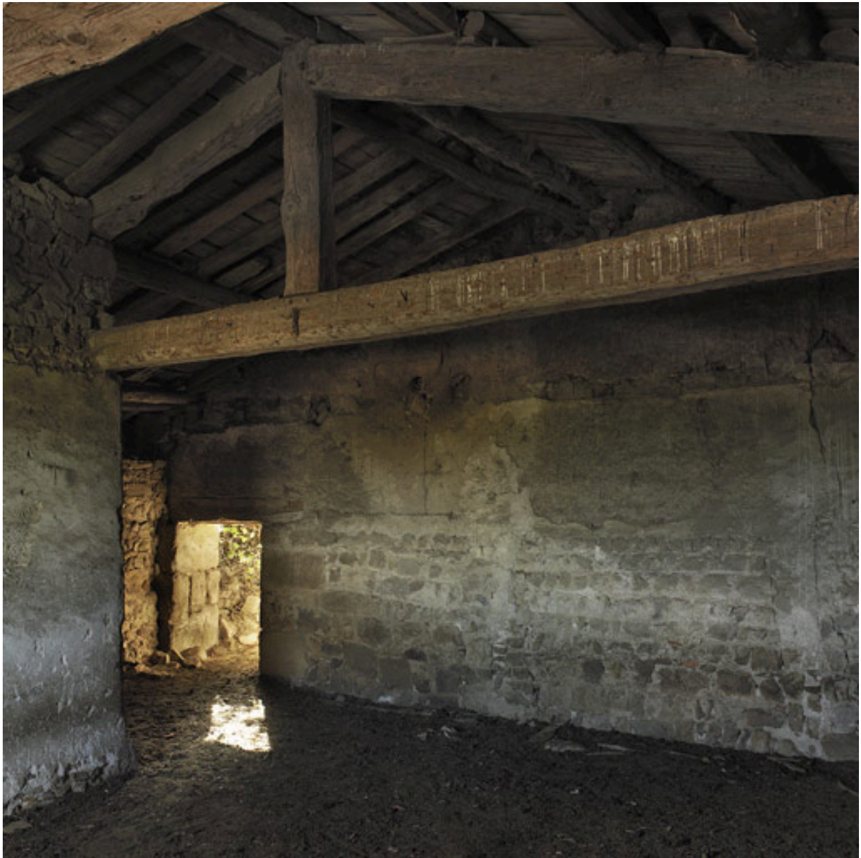
Vue intérieure du rez-de-chaussée surélevé du bâtiment nord-est.
