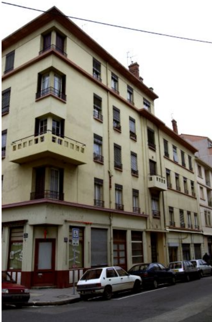
Vue d'ensemble de l'angle de la rue Ravat et de la rue Delandine
