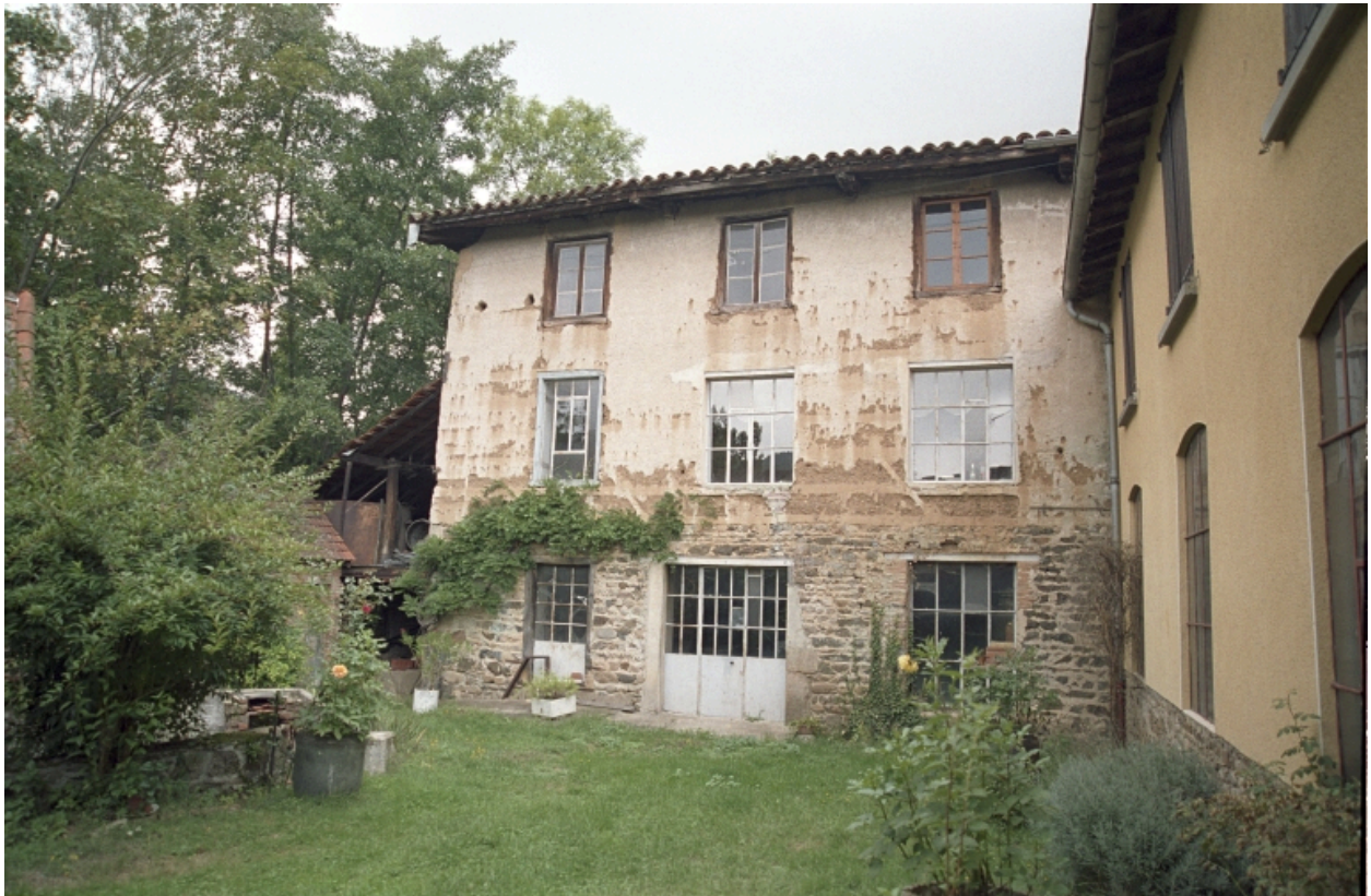
Façade arrière sur cour de la carderie, vue d'ensemble.
