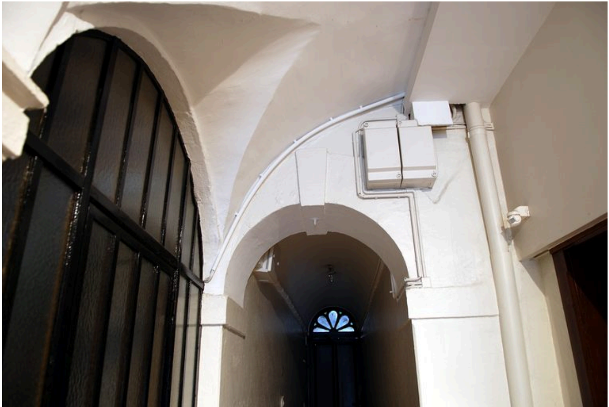
L'allée au niveau du départ d'escalier : vue partielle du couvrement
