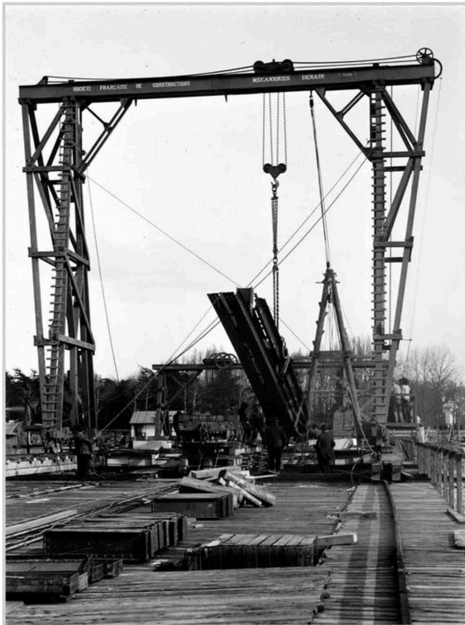
La construction du pont de la Boucle. la pose des poutrelles des arches supérieures.
