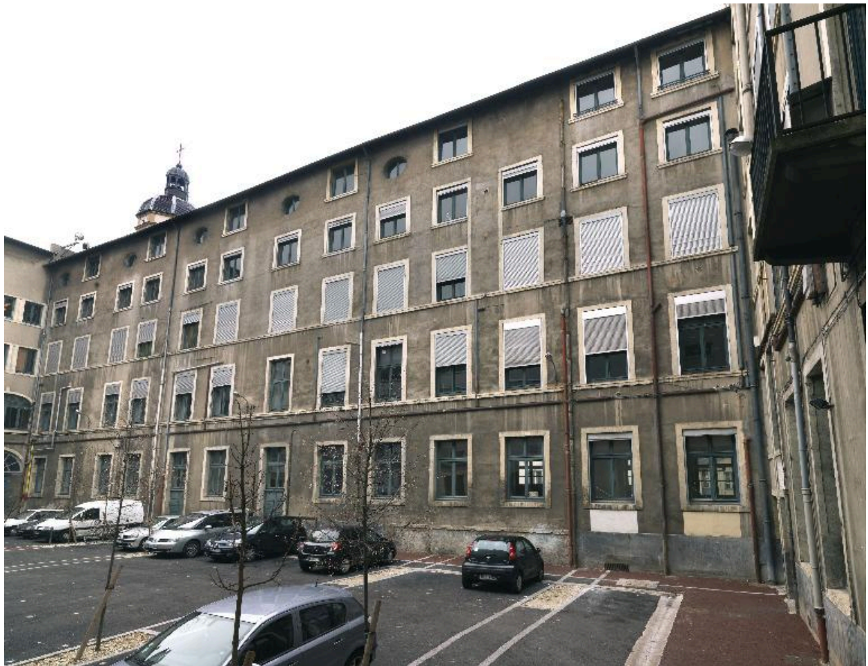
Cour des cuisines élévation latérale ouest
