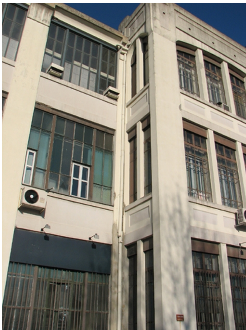
Détail ouest d'un avant-corps
