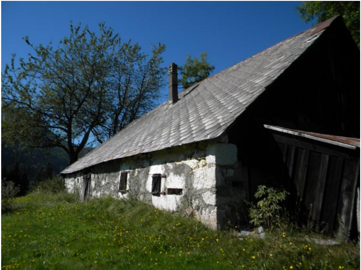
Vue de la façade arrière et du pignon nord.
