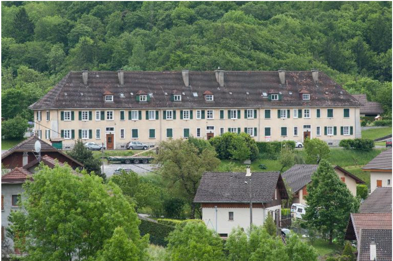
Vue de la façade principale depuis le château.
