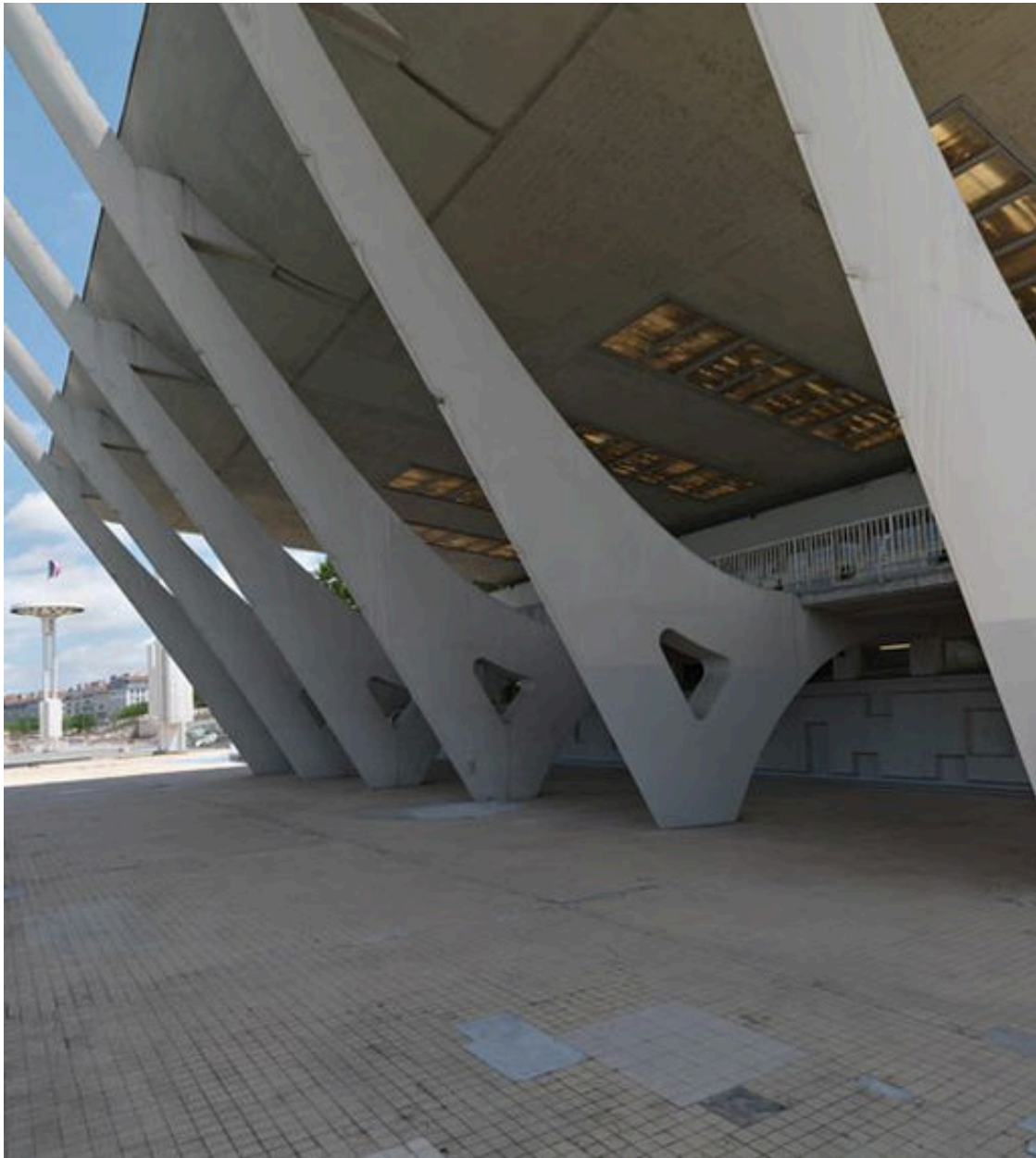
Détail du soubassement du bâtiment d'exploitation (état juin 2012).
