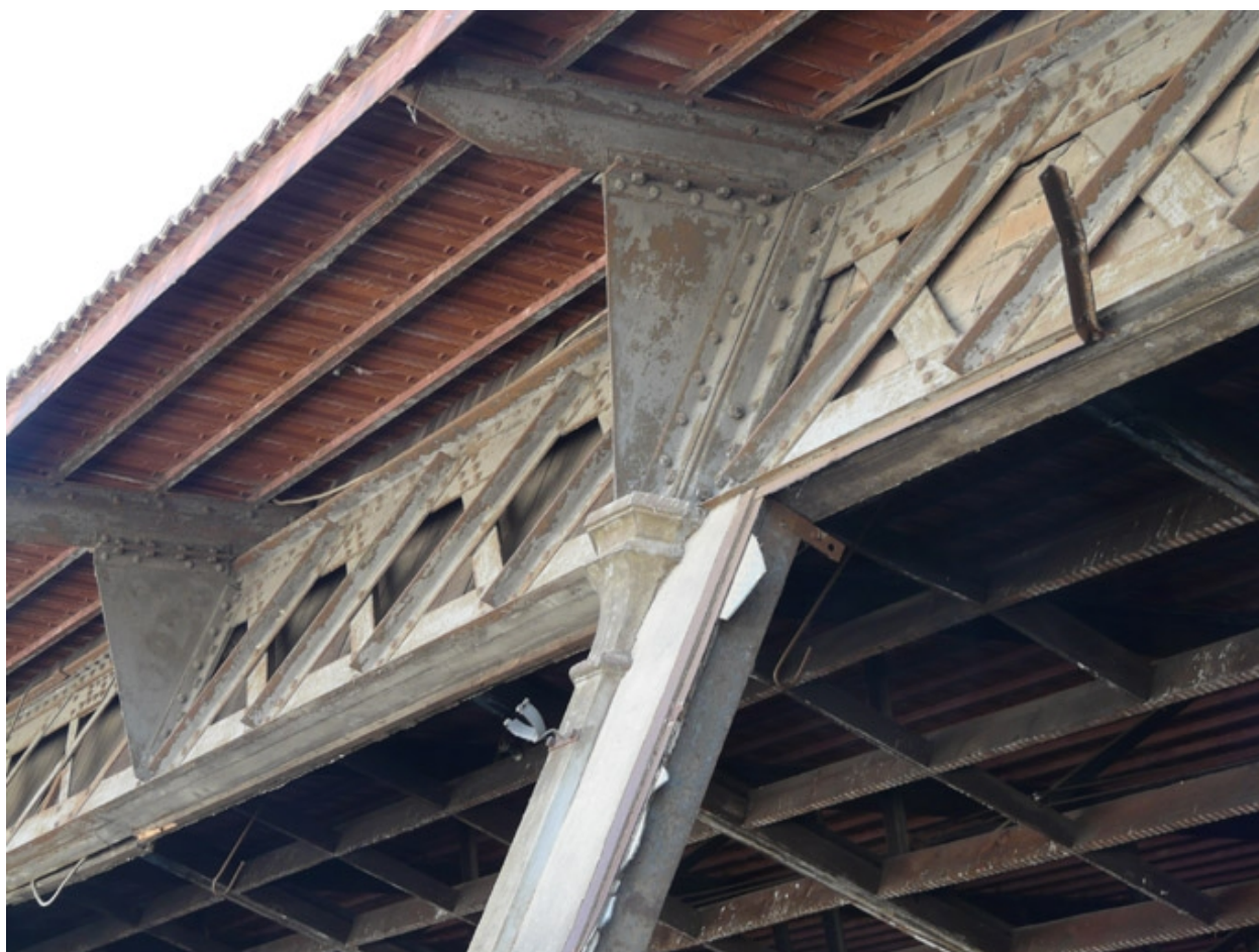
Détail structure métallique de la grande halle (n° 76)
