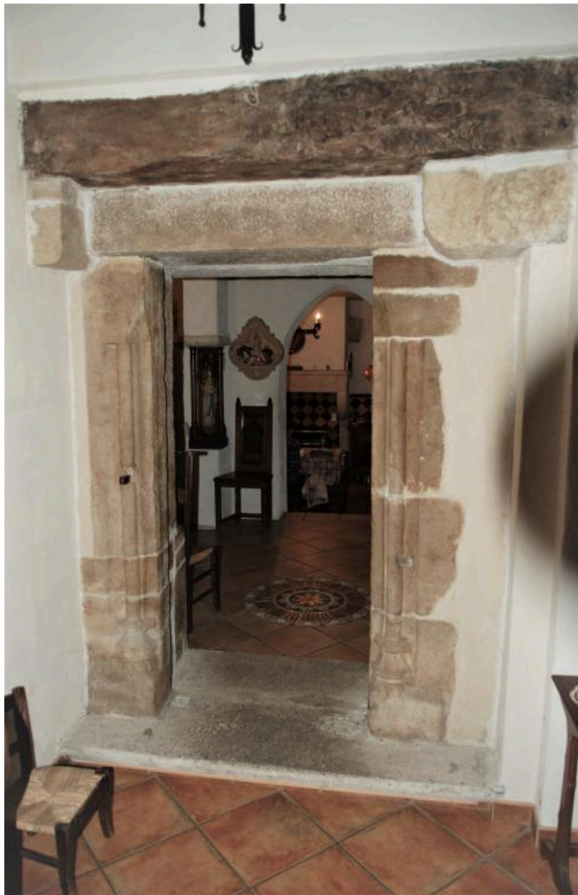
Rez-de-chaussée de la maison forte, détail de la porte de la pièce située à droite en entrant, à l'opposé de la grande pièce.
