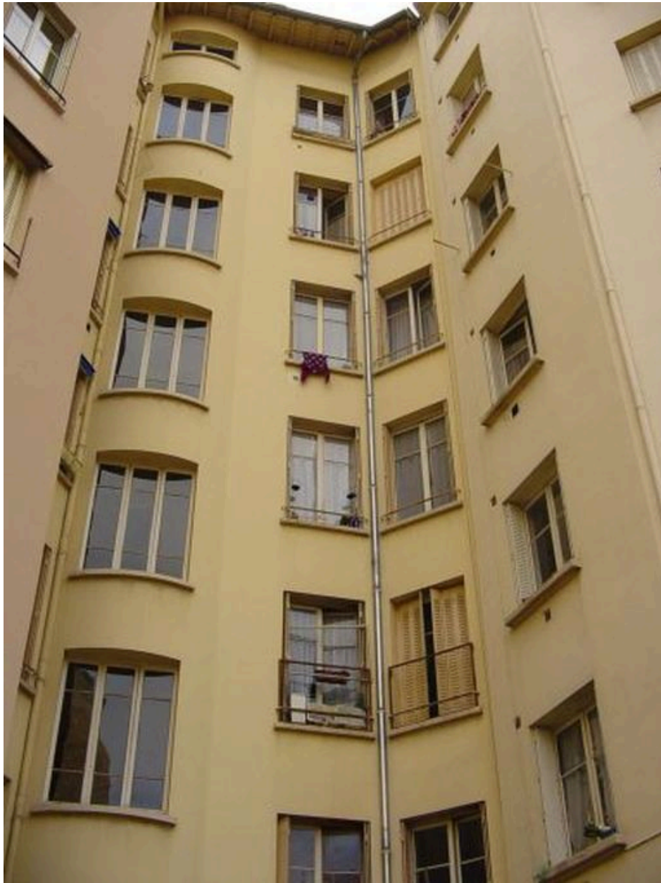
Elévation postérieure sur cour
